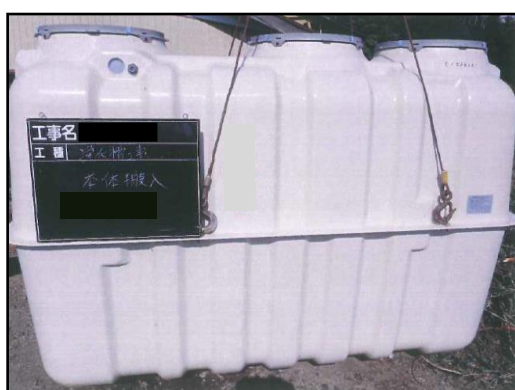
浄化槽本体の吊り込み
