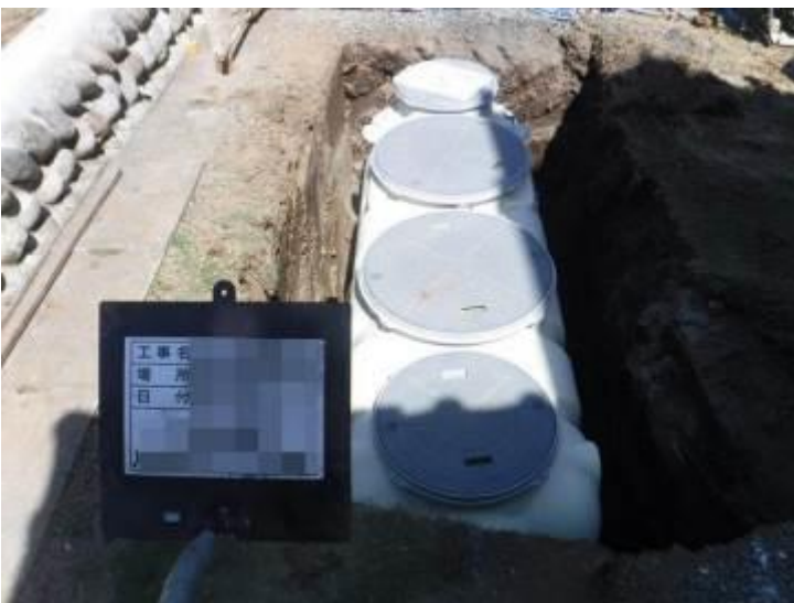
⑧合併処理浄化槽設置
