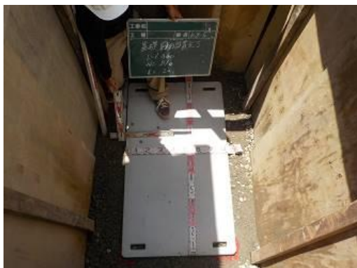
GRC製底板の据付
