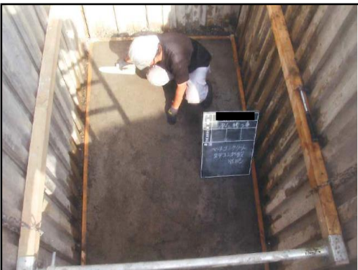
捨てコンクリートの打設
