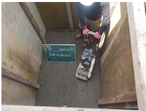
砕石作業の突き固め
