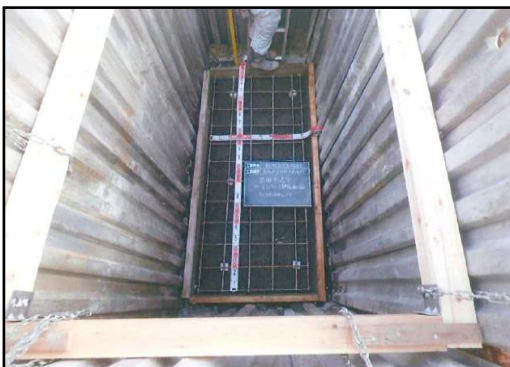
基礎コンクリートの配筋
