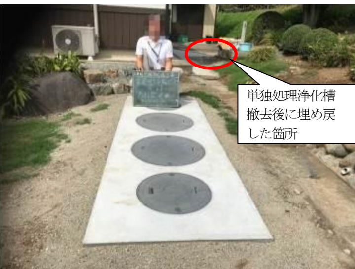
⑨工事完了
