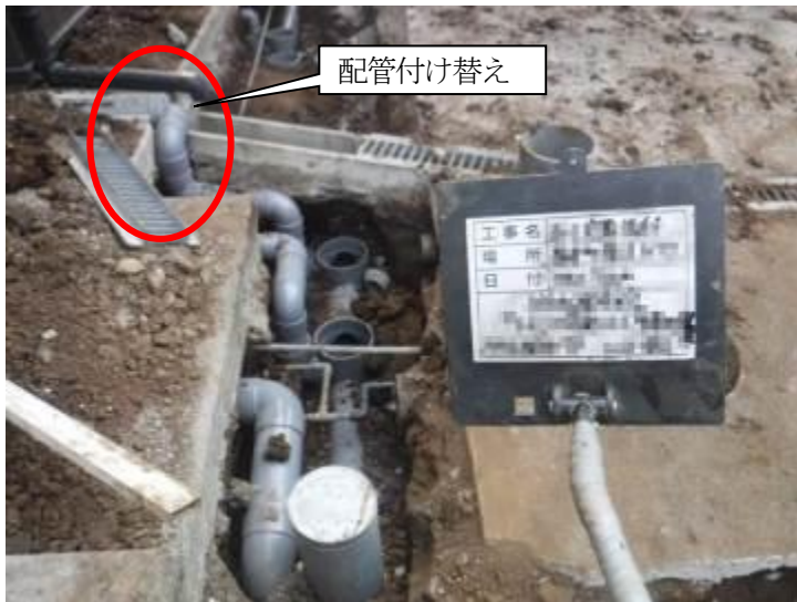
⑦配管付け替え工事
