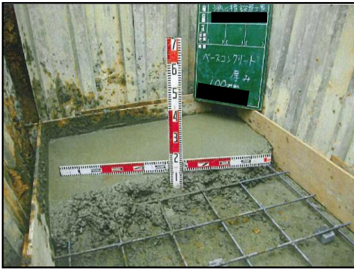
コンクリートの打設
