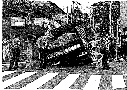
陥没した道路にダンプカーがはまる事故も起きている
